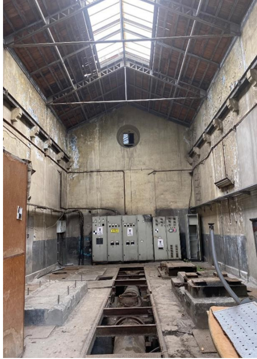
Şekil 2. Feriköy Su Deposu iç mekan görüntüsü
