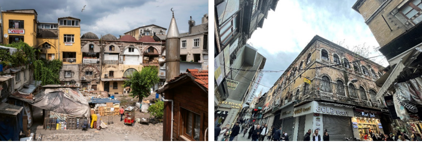
Şekil 2. 1 Günümüzde yanlış müdahaleler ve kullanımlar nedeniyle fiziksel ve işlevsel açıdan zarar görmüş hanlardan biri, Balkapanı Han (solda) (URL 3) ve Bakımsızlık ve ilgisizlik nedeniyle cephesi zarar görmüş hanlardan biri, Giritli Mustafa Paşa Hanı (sağda) (Kişisel arşiv, 2023)
